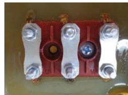
Resim 3: Klemens üzerinde üçgen bağlantı
